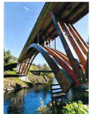
Die Holzeuropabrücke – die längste für den Schwerverkehr zugelassene Holzbrücke in Europa mit einer Spannweite von 85 m und das Aushängeschild aller Holzwelt-Objekte.
